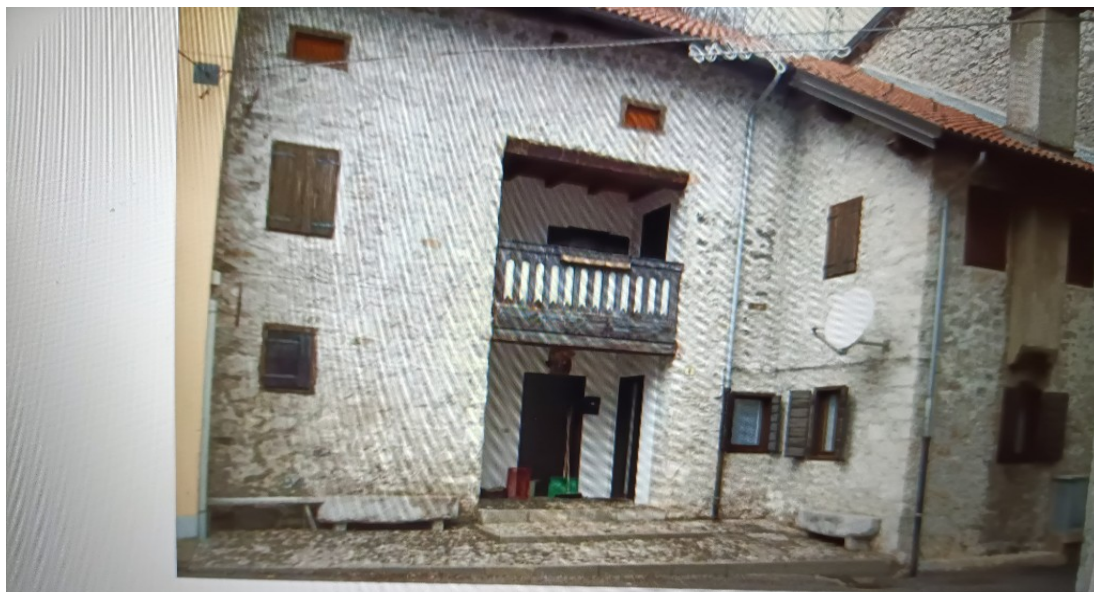
Foto 3: Prospetto Est fabbricato
